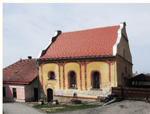
Synagoga v Batelově s novou střešní krytinou
