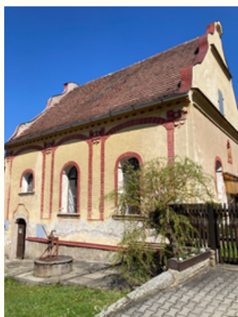
Synagoga v Batelově původní stav
