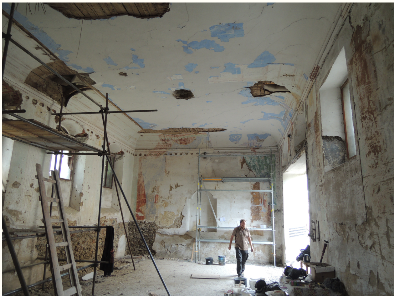
Rekonstrukce synagogy v Neveklově, červen 2024.
