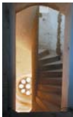
Kamenné schodiště na galerii.
