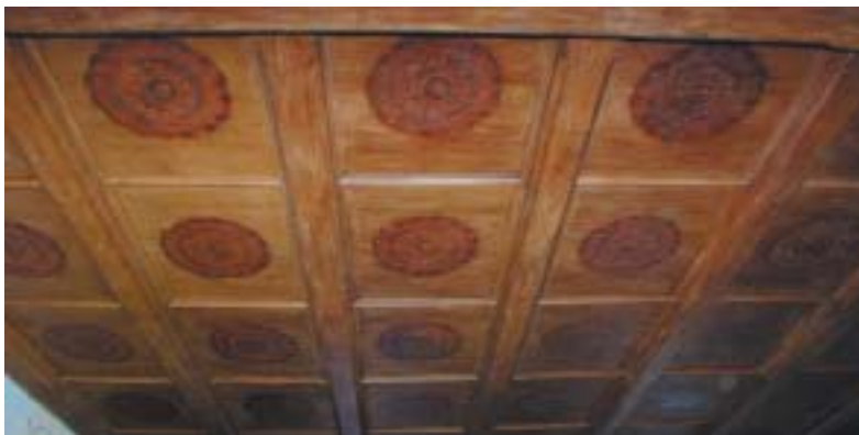
Restaurovaný strop Staré synagogy v Plzni.
