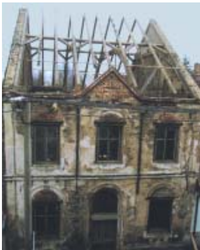
Rekonstrukce krovy, 2003. Foto Občanské sdružení Památník Hartmanice.
