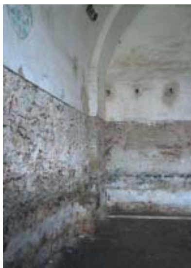
Pohled do interiéru po odstranění zásypů. Foto archiv.
