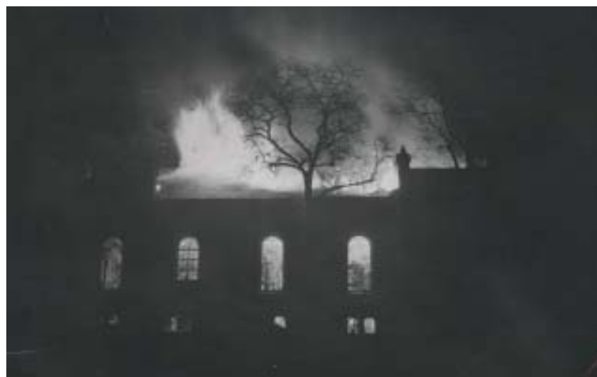
Hořící synagoga v Mostu. Foto Státní okresní archiv Most.
