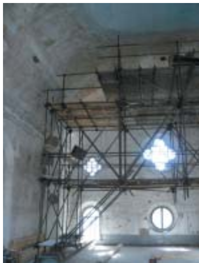
Práce na interiéru písecké synagogy.
