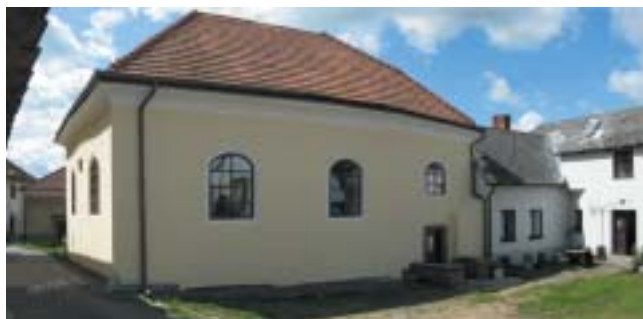
Synagoga – dnešní stav, pohled od severovýchodu. Foto Jiří Stach.
