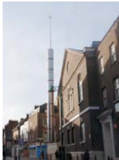
Bývalá Velká synagoga v Brick Lane, nyní mešita.
