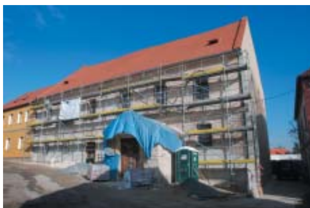
Brandýs – práce na fasádě.
