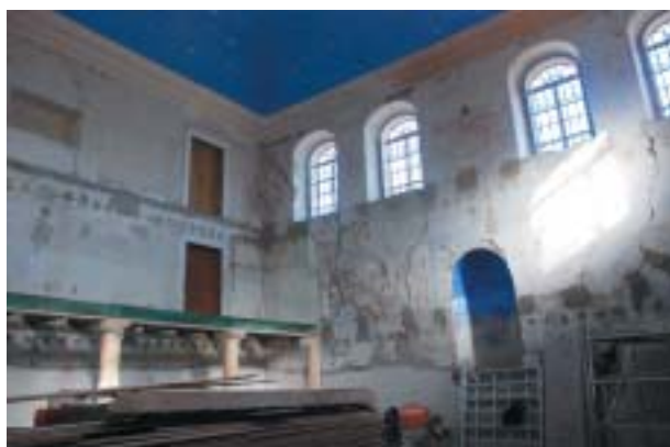
Brandýs – nové sloupky nesoucí galerii.
