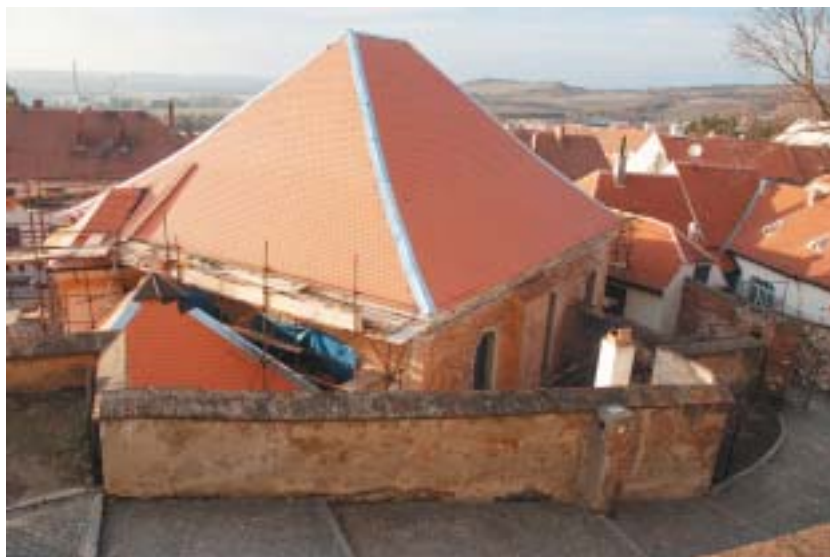
Mikulovská synagoga má nový krov i střechu.
