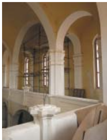
Pohled do obnovené ženské galerie.
