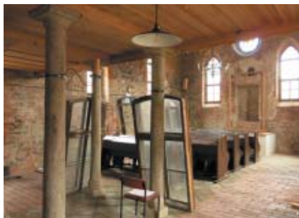
Pohled do synagogy – současný stav. Foto na této dvoustraně J. Daniček.
