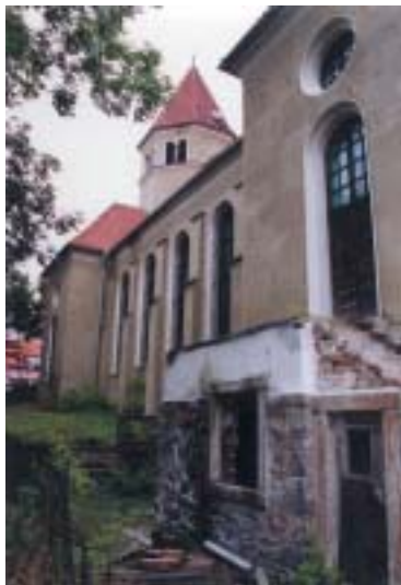
Jižní fasáda před zahájením oprav. Foto A. P. 2003.
