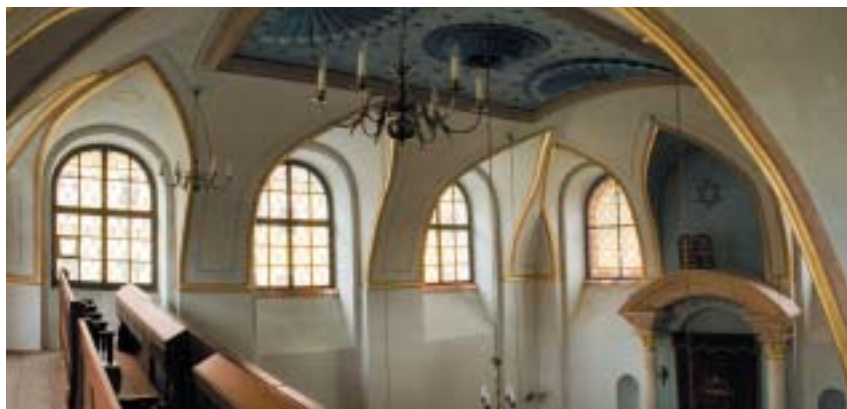
Obnovená výmalba stropu a zlacení.
