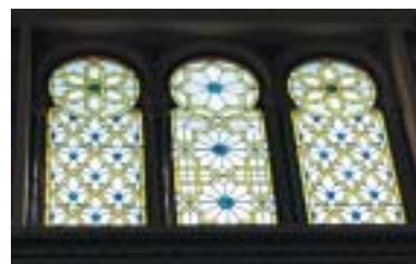
Obnovené okenní vitráže.
