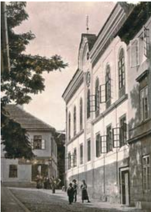
Západní průčelí synagogy v Příbrami, foto z roku 1900.
