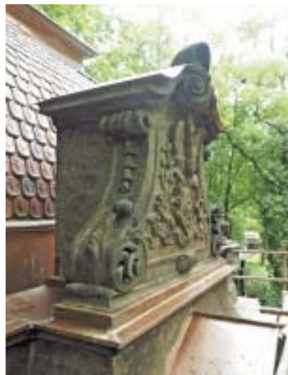
... a poté, co byly rekonstruovány chybějící části.
