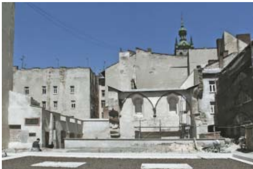
Zbytky zdi synagogy Zlaté růže s místem pro budoucí památník Prostor synagog.
