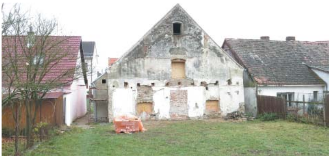
Pohled na synagogu v Polici od západu (listopad 2016) dokumentuje zachovanou původní zástavbu Židovské ulice z poloviny 18. století.
