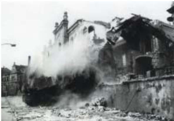
Demolice synagogy v Táboře, 1977.
