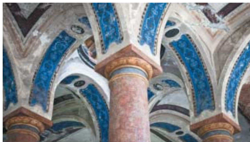
Obnovená klenba synagogy. Foto T. Stern.
