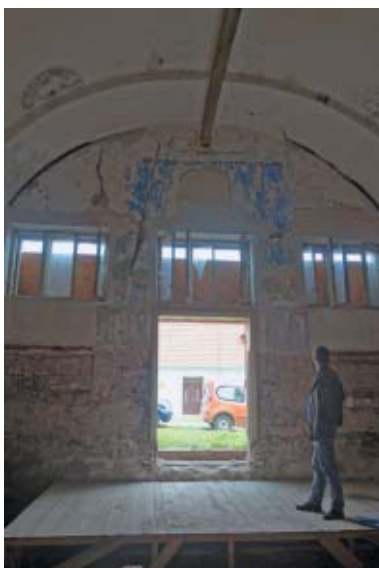
Východní stěna synagogy, stav v roce 2012.
