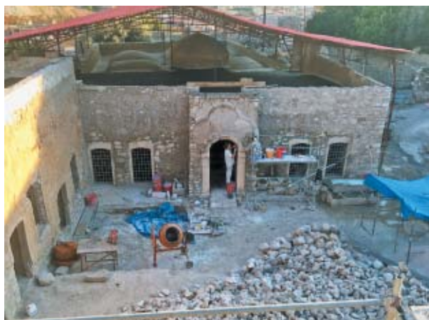
Renovace portálu synagogy. Foto archiv.
