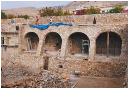
Dokončení rekonstrukce arkád synagogy. Foto archiv.
