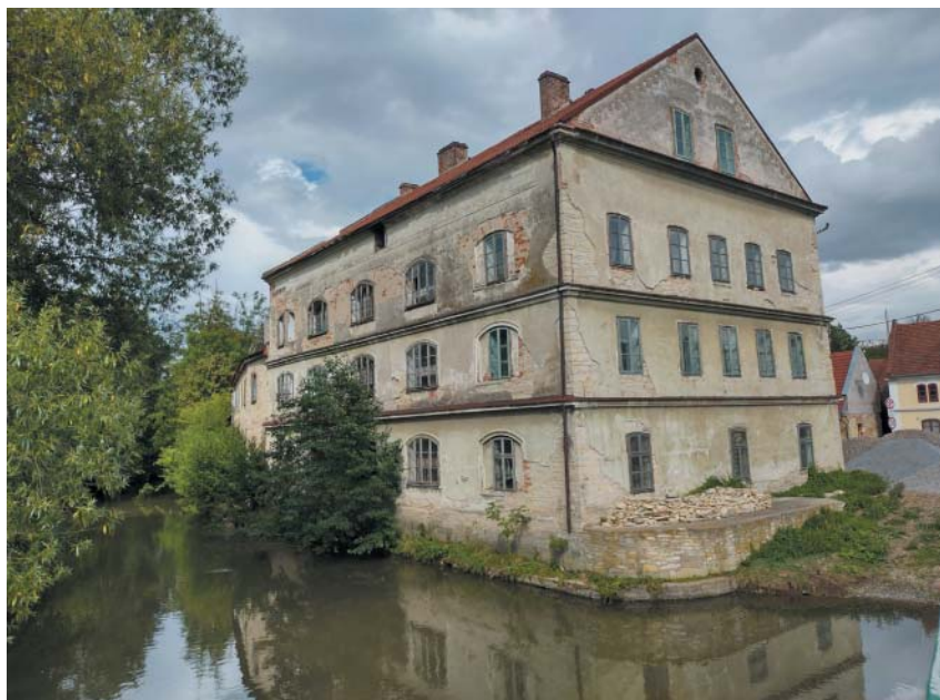
Luže čp. 75, krásný, ale zchátralý dům na řece Novohradce. Bývalá koželužna Eliáše Poppera; v červenci před ní byly položeny Stolpersteiny za rodinu Vielgutovu. Foto A. Marxová.
