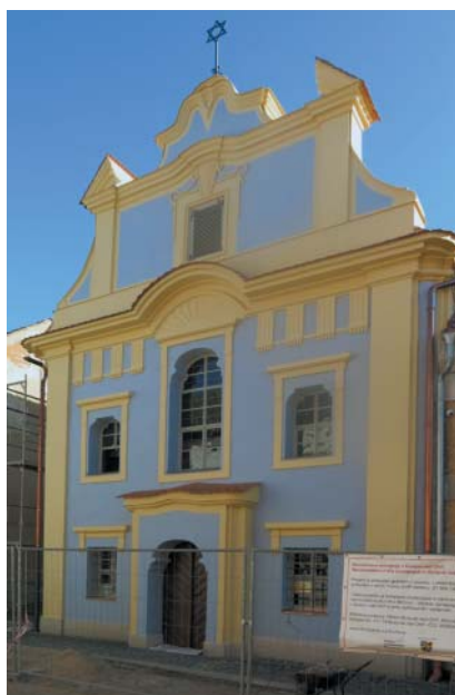
Obnovené pozdně rokokové průčelí. Foto jd.
