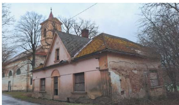
Bermannův dům, po požáru v roce 1930 znovu postavený, současný stav.
