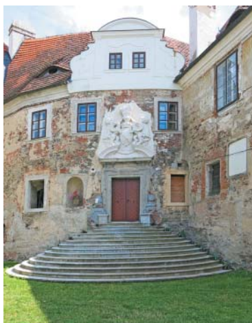
Vnější barokní schodiště zámku Ronšperk.
