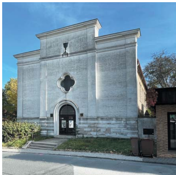
Jubilejní synagoga v Hořovicích, Valdecká 408, dnešní stav.
