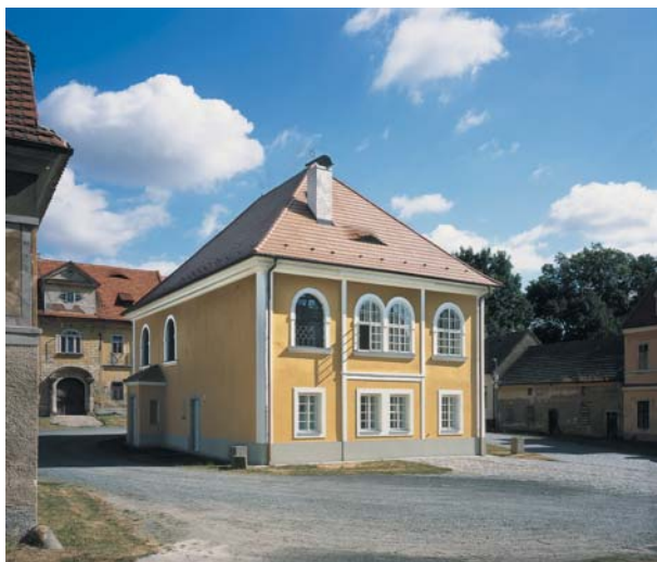
Pohled na březnickou synagogu od jihu. Foto Libor Teplý.
