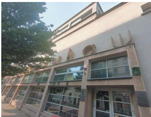
Průčelí, současný stav.
