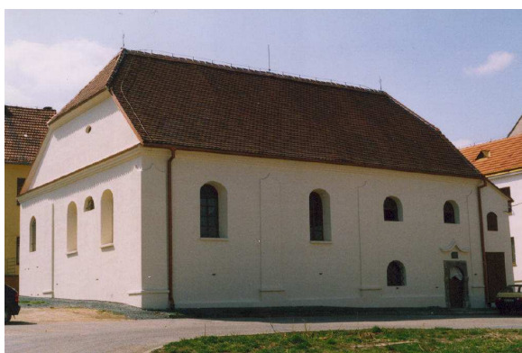
Synagoga v Dolních Kounicích
